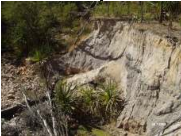
Abbildung 16 Die Auswirkungen der schlechten Böden sind katastrophal. Können diese Erosionen noch aufgehalten werden?
